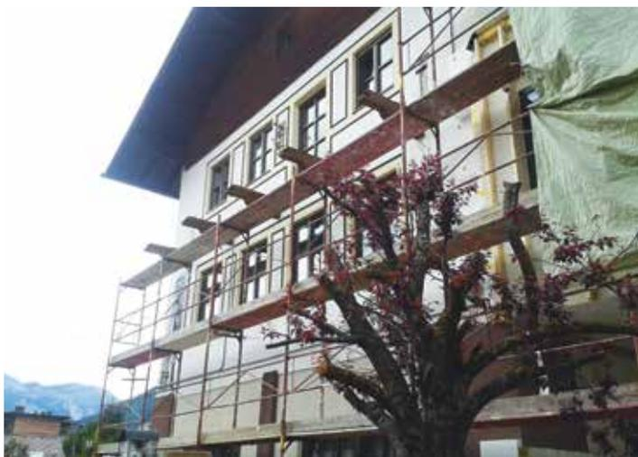
Einrüstung zur Anbringung der Wärmedämmung,
