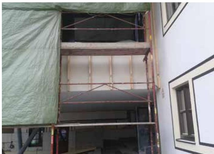
Anbringung der Unterkonstruktion für die Holzfassade
