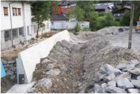
Ende April wurde mit den Verbauungsmaßnahmen für die Regulierung des Ampelsbaches begonnen. Zwischenzeitlich ist das Ergebnis der bisherigen Bautätigkeiten recht gut erkennbar. Der Bereich von der Brücke der B 181 Achensee Straße bis zum Gerätehaus der Fraktionsfeuerwehr ist linksufrig fast fertiggestellt.
