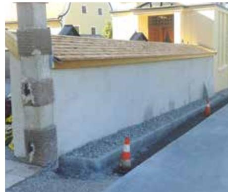
Die Arbeiten am Friedhof in Eben sind kurz vor Vollendung: Das Schindeldach ist bereits montiert, die äußere Mauereinfassung wurde mit Steinen aufgefüllt und mit den Asphaltierungsarbeiten konnte begonnen werden.
