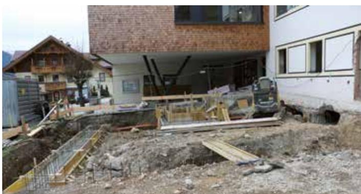
Die Bauarbeiten schreiten zügig voran. Im Erdgeschoß wurde schon das Fundament für das Gebäude und den Lift betoniert.
